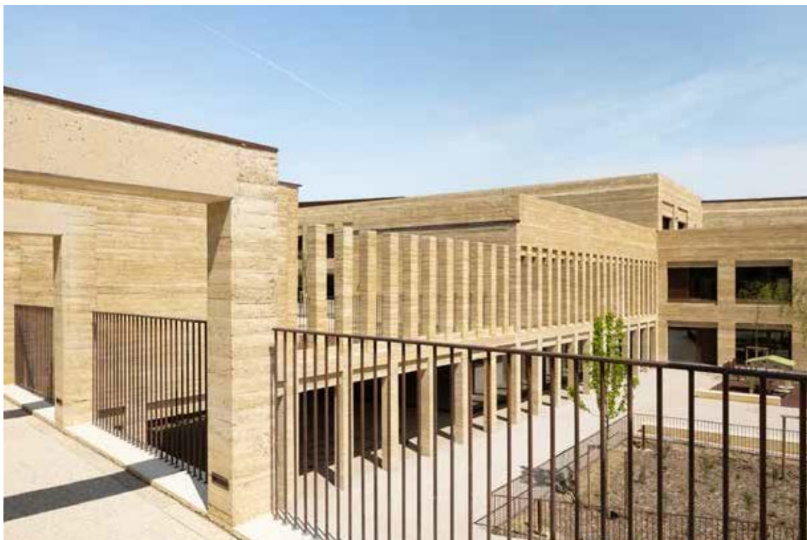
Ensemble scolaire à Châtenay-Malabry.
