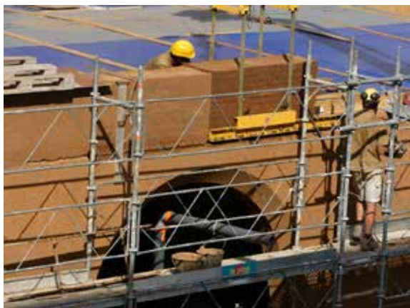
Construction de l'Orangerie à Lyon.
