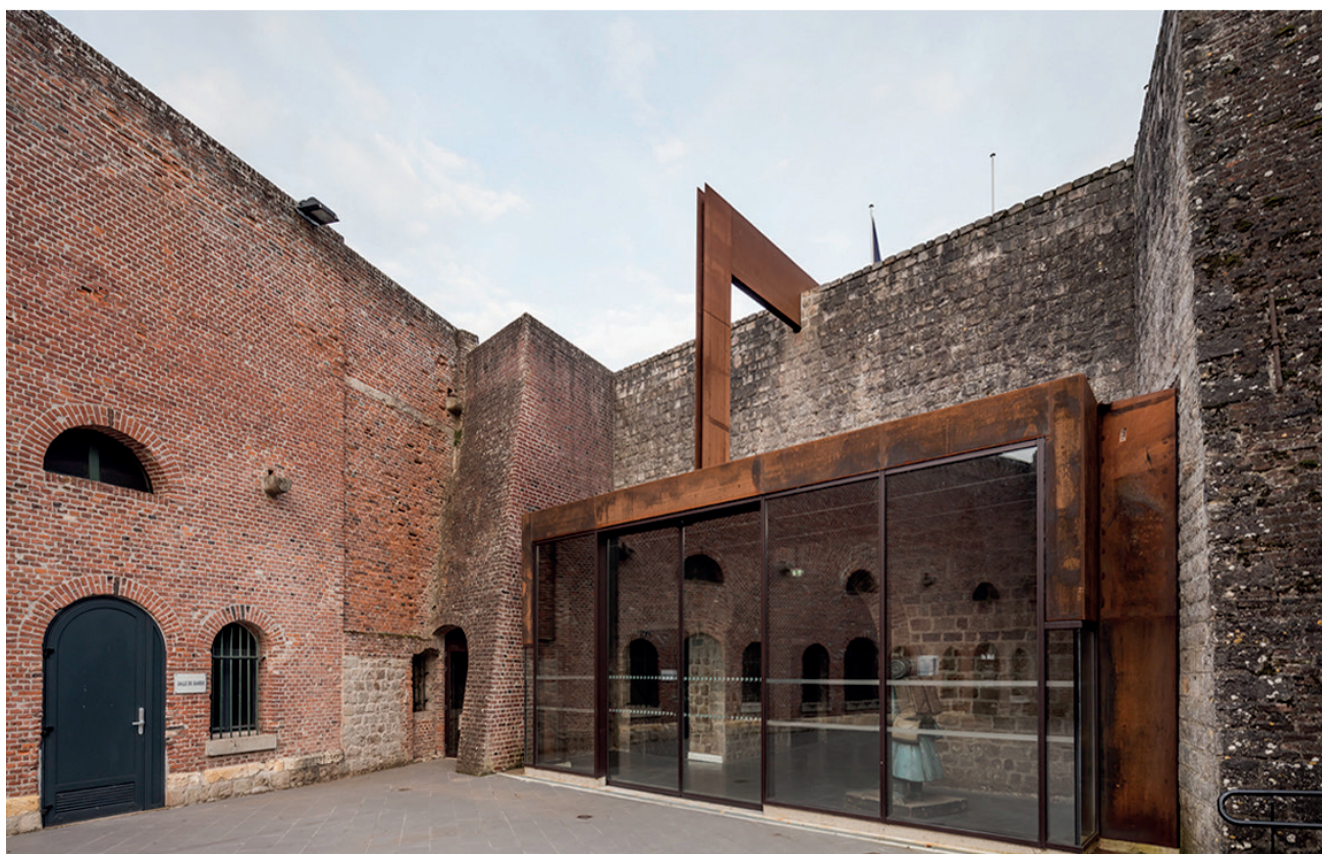
Entrée de l'Historial dans le Château de Péronne. Architectes : Emmanuelle Beaudouin, Laurent Beaudouin, Paolo Tarabusi.
