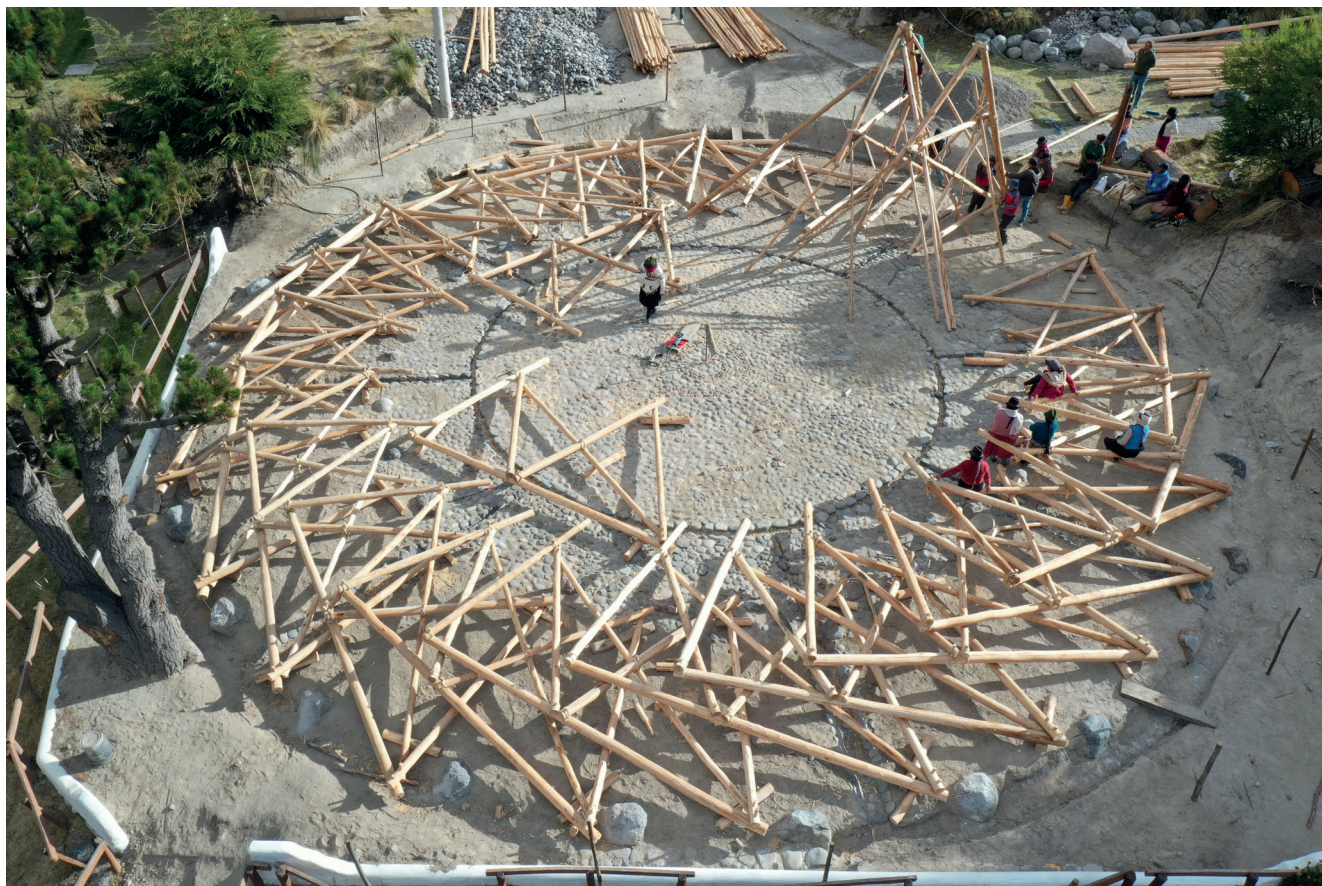
Process de construction du centre d'artisanat Chaki Wasi.
