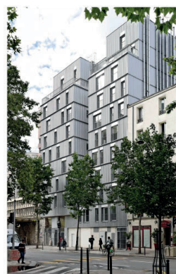
LE BÂTIMENT SUR L'AVENUE DE CLICHY AU DROIT DU PONT DE LA PETITE CEINTURE
