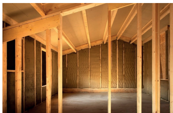
Terlian, technologie brevetée pour une offre de solutions constructives à base de terre d'excavation - SGDB France.
